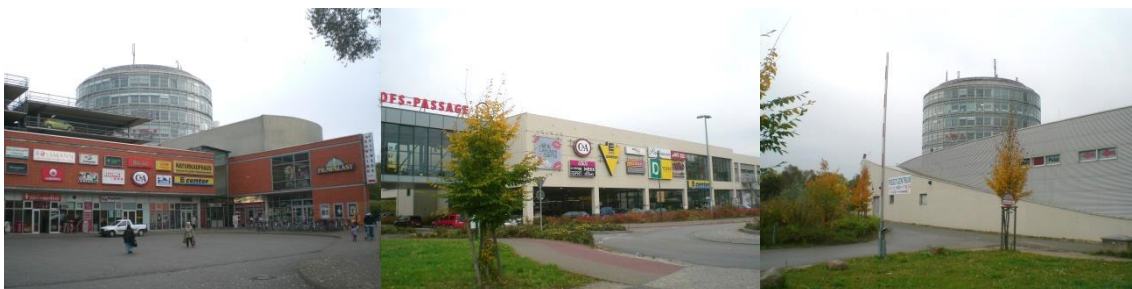
Abb. 11: Ansichten zum B-Zentrum EKZ „Bahnhofs-Passage“
